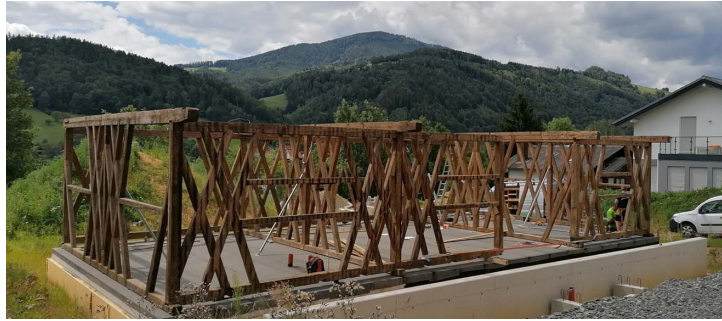
Kreatives Projekt – ein altes Stadel wurde in der Südsteiermark abgebaut und als Wohnhaus in Anger wieder neu aufgebaut und restauriert.
